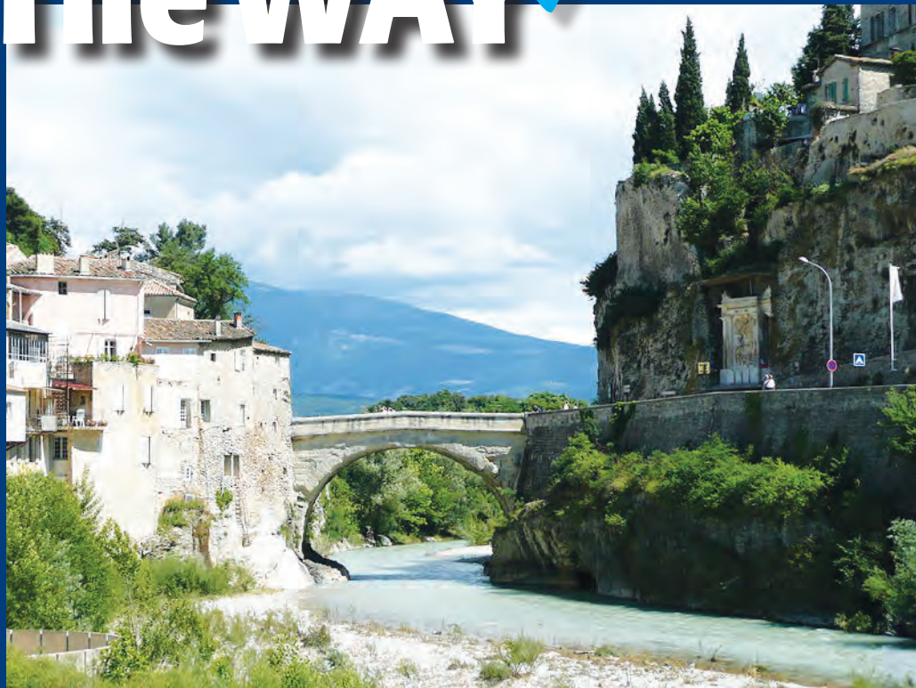
Vaison-la-Romaine Bridge in France
